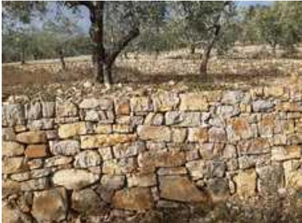
In questo caso la ricostruzione del muro è stata fatta con materiale del luogo, alberese di varia qualità ma sempre di pezzatura pregevole e facilmente maneggiabile. Le pietre più irregolari sono state mantenute in fondo al muro mentre quelle squadrate sono andate a costituire un disegno armonico e vario sia da un punto di vista costruttivo che cromatico. Le varie pietre presenti hanno infatti donato una colorazione particolarmente luminosa al terrazzamento.
